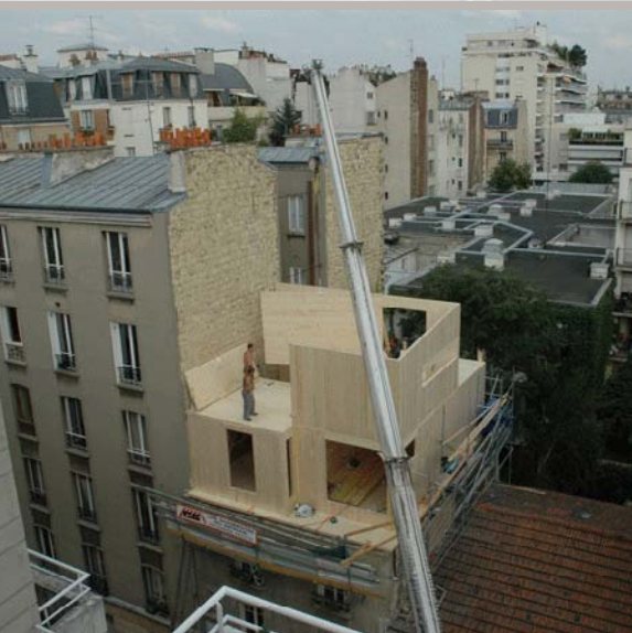
Surélévation Rue Delbet
